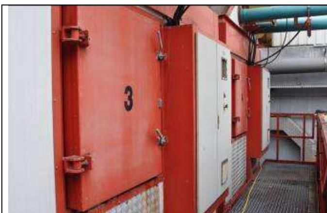
Für die ersten zehn Tage kommt der kompostierbare Biomüll in die Intensivrotte. In Pfaffenhofen findet diese erste Rottephase in vier großen Containern statt, die eher wie große Garagen aussehen. Innen drin wird allerdings über Bahnen am Boden das Material ständig bewegt und umgeschichtet, da Temperaturen bis über 90°C entstehen! Die mikrobielle Umsetzung heizt den Kompost soweit auf, bis die Mikroorganismen selbst absterben und der Kompost hygienisch ist.
