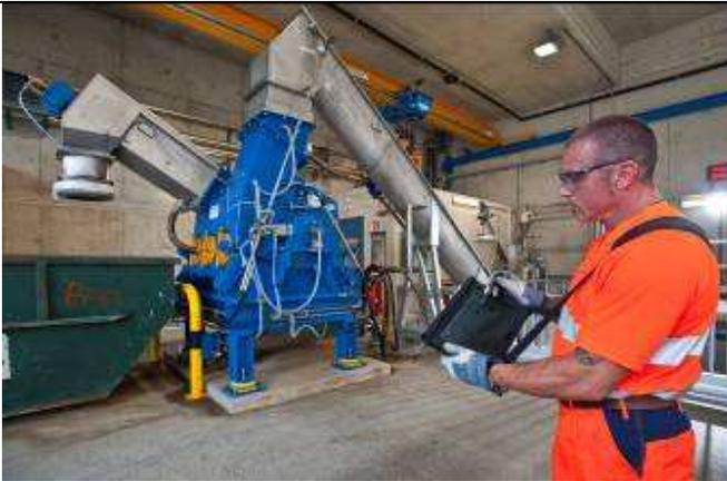
Der erste Teil der Substratanlage ist die Hammermühle.
