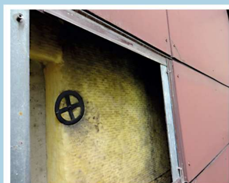
Bsp.: 3a_Außenfassade mit KMF-Dämmung
