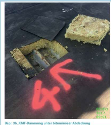
Bsp.: 3b_KMF-Dämmung unter bituminöser Abdeckung
