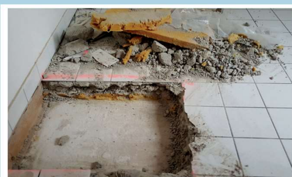
Bsp.: 4_Trittschalldämmung aus KMF
