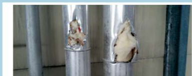
Bsp.: 1_Rohrummantelung aus KMF
